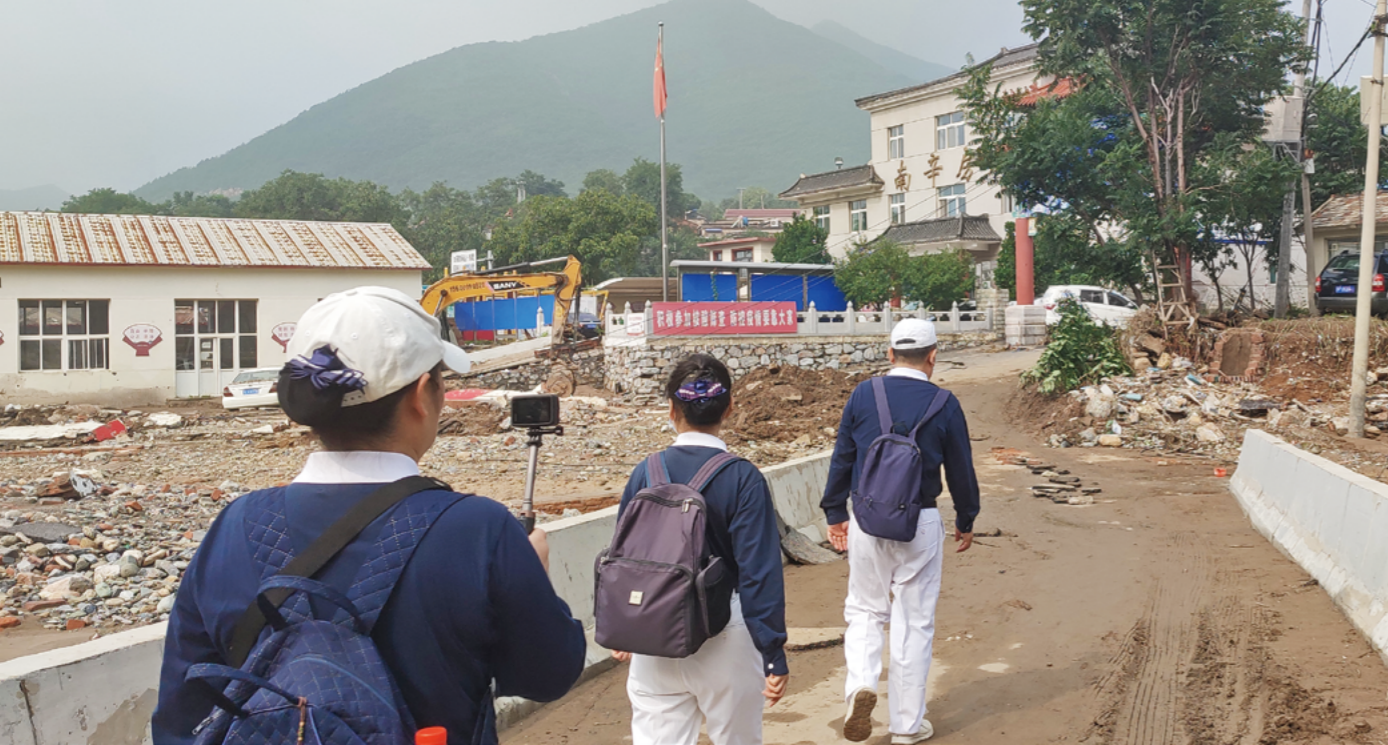
快到南辛房村，目之所及，都是被洪水冲坏的路面、房屋，厚重的淤泥夹带着垃圾，让空气中弥漫着一股发霉的味道。摄影/马莉
