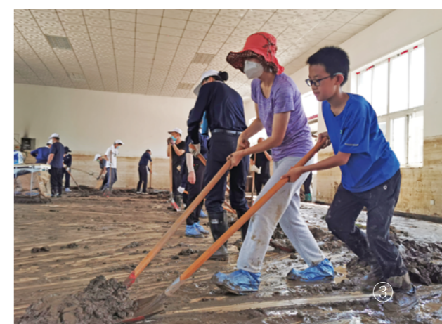
图①：没有顺手的清淤工具，志工罗庆颖和上大二的儿子罗翊恩找到一块废弃的桌板，两人一起把淤泥往外推。摄影/刘毅
