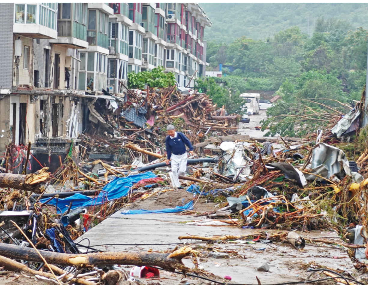
潭柘寺镇受灾严重的潭墅苑小区18号楼，泥石流冲进地下室和一楼，连接一期与二期的小桥被洪水冲毁。摄影/刘燕斌
