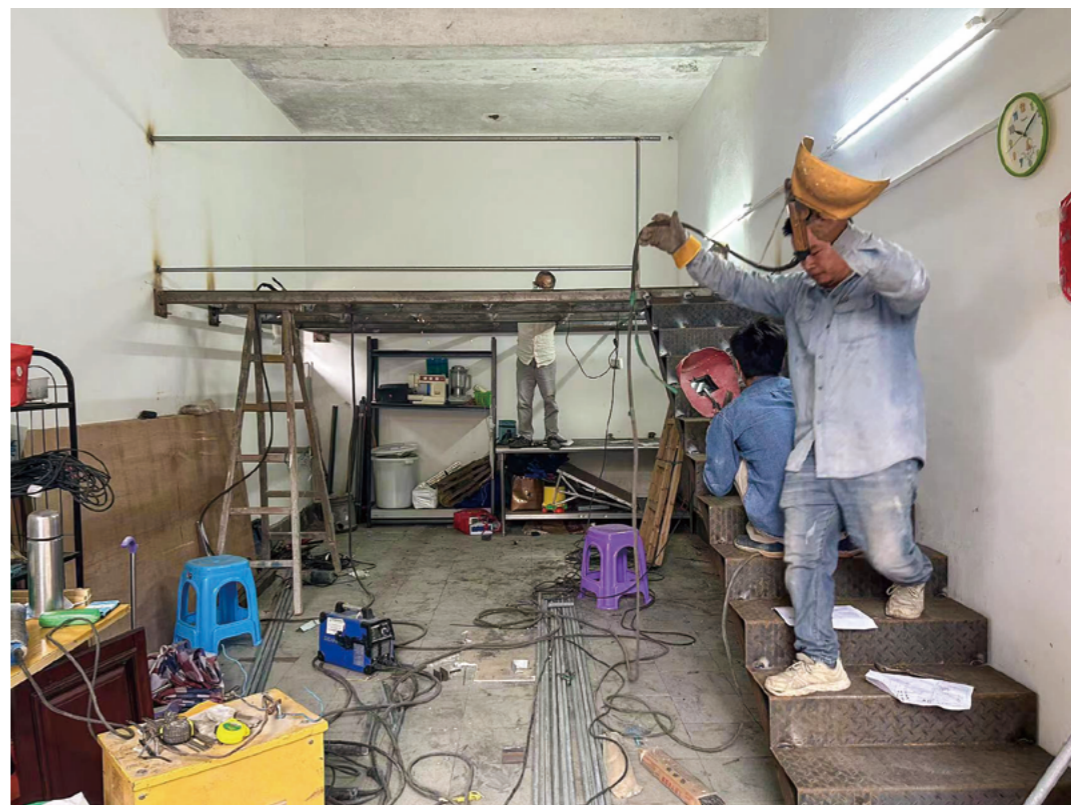
环保站做隔层装修，装修师傅不仅要焊接楼梯隔板和隔层底板，还要进行打磨、刷防锈漆等步骤。摄影/郭孝光
