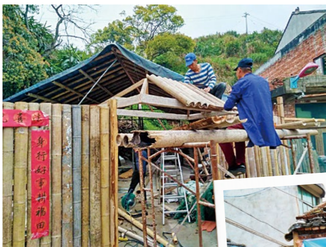
崂山东角环保站是志工们花了三天的时间搭建完成的，里面使用到的篷布、铁管、竹子等材料全都是回收再利用的。摄影/郑尔婷
