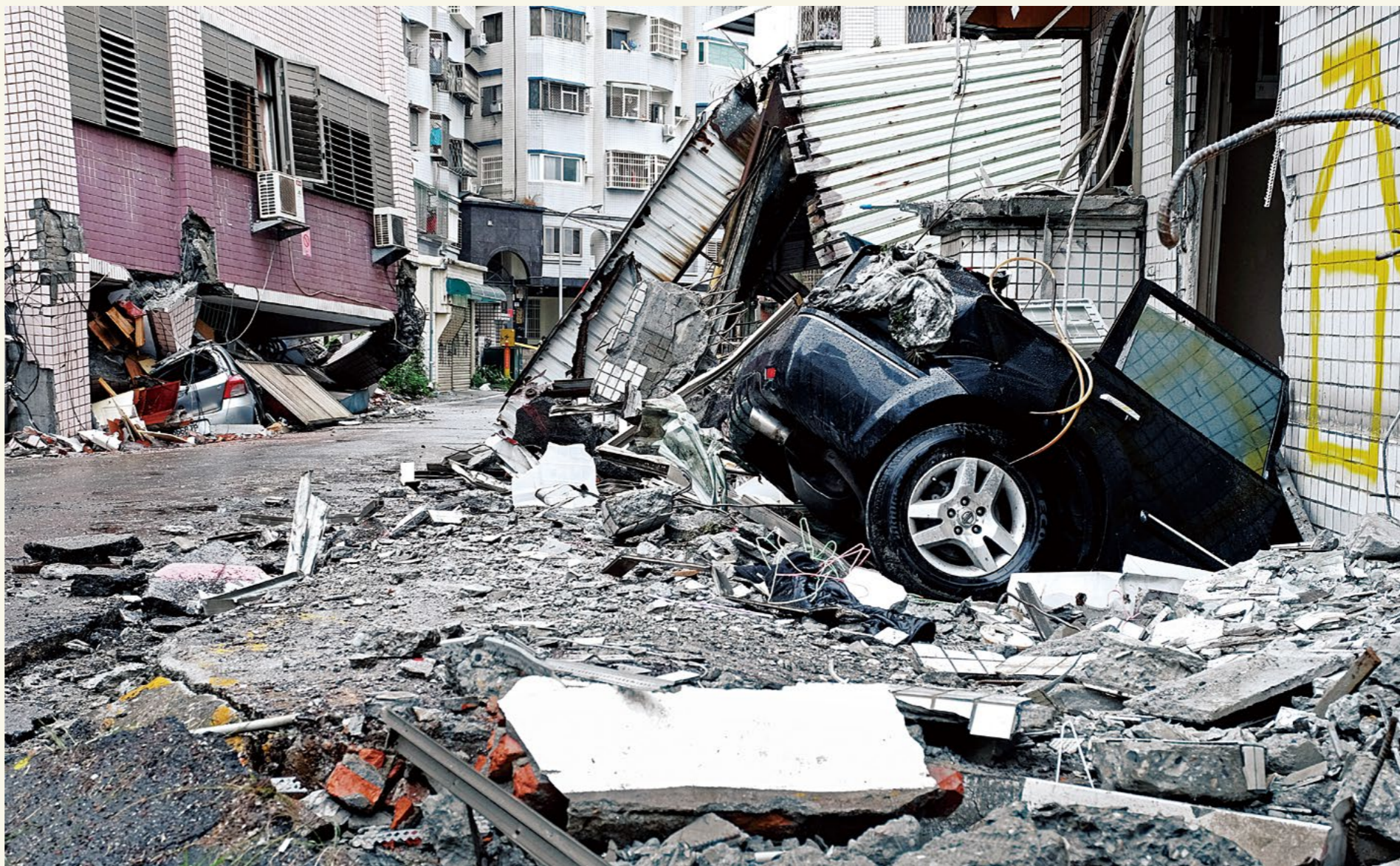
处于斜对角的国盛六街“白金双星”和“吾居吾宿”两栋楼，地震坍塌，有住户紧急跳在毁坏的汽车上头，仓皇逃离。
