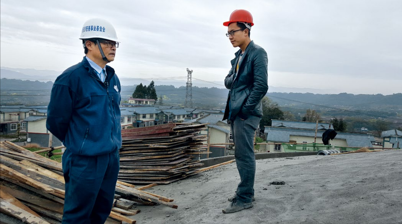
慈济基金会营建处驻四川同仁邓乃仁（左）站在前进幼儿园屋顶，查看屋顶的防水工程施工细节。慈济重视校舍建筑质量，在灾难来临时要能成为社区的避难所。（摄影/曾忆玲）
